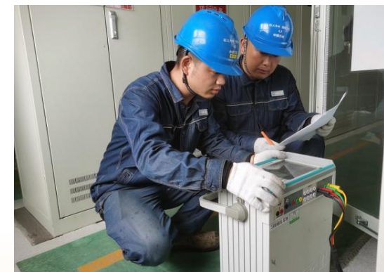
宁夏分公司检修团队处理发电设备缺陷
