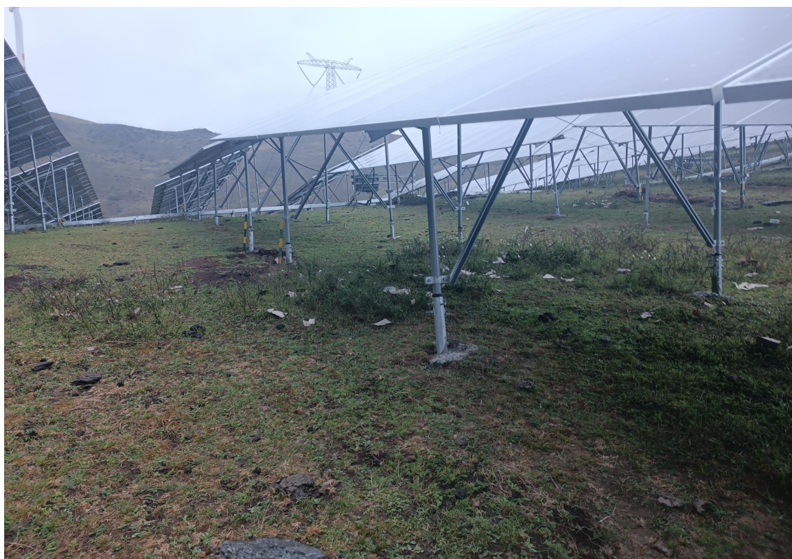
图 3.7 光伏区植被恢复情况（2023 年 8 月拍）
