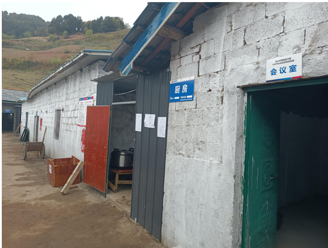
图 1.2 施工办公、食宿临时租赁村民房屋（一）
