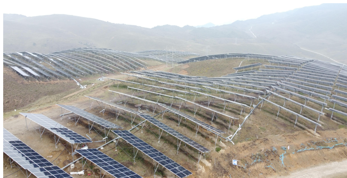
图 3.5 光伏板之间未扰动区域植被恢复情况(2023 年 6 月拍)
