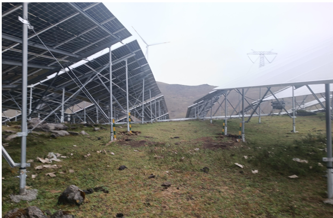
图 3.8 项目光伏支架基础施工对地表扰动情况调查（2023 年 8 月拍）
