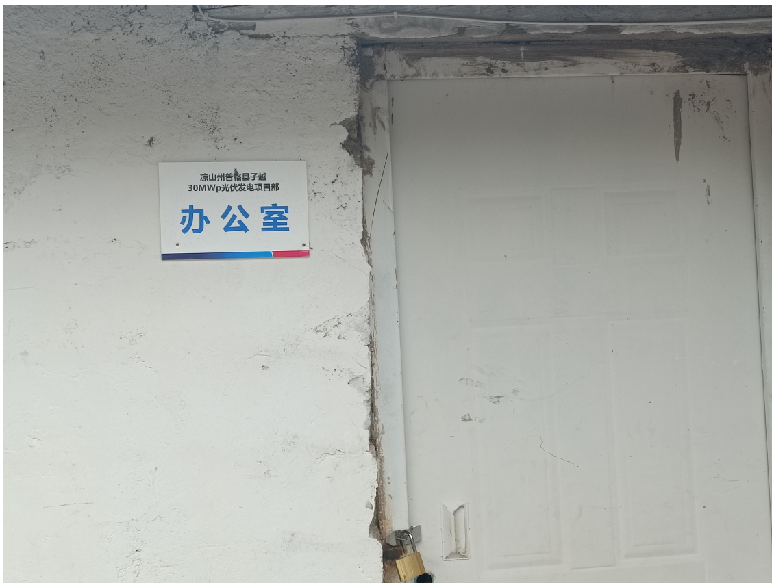
图 1.3 施工办公、食宿临时租赁村民房屋（二）
