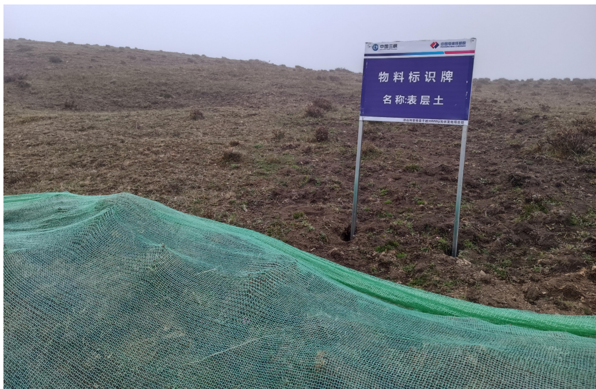
图 3.21 表土剥离及表土临时堆放区（引自施工期监测照片）
