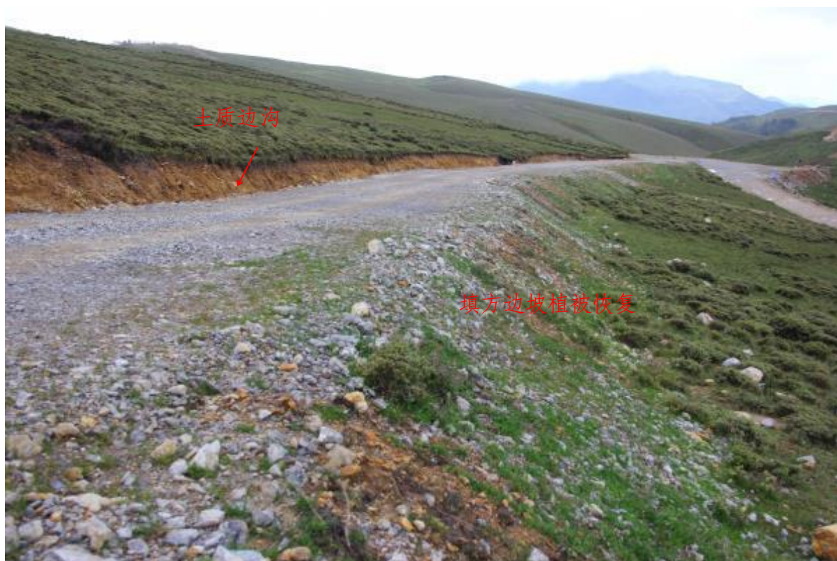
图 3.15 道路工程区路基土质边沟及填方边坡植草绿化（2023 年 8 月）
