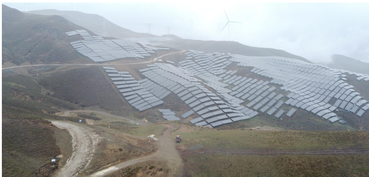
图 3.6 光伏区植被恢复情况（2023 年 7 月拍）
