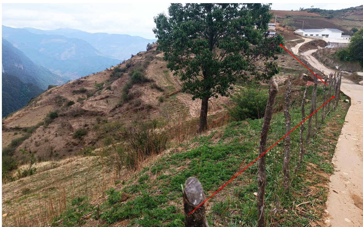
图 3.13 沿既有道路敷设段植被恢复情况
