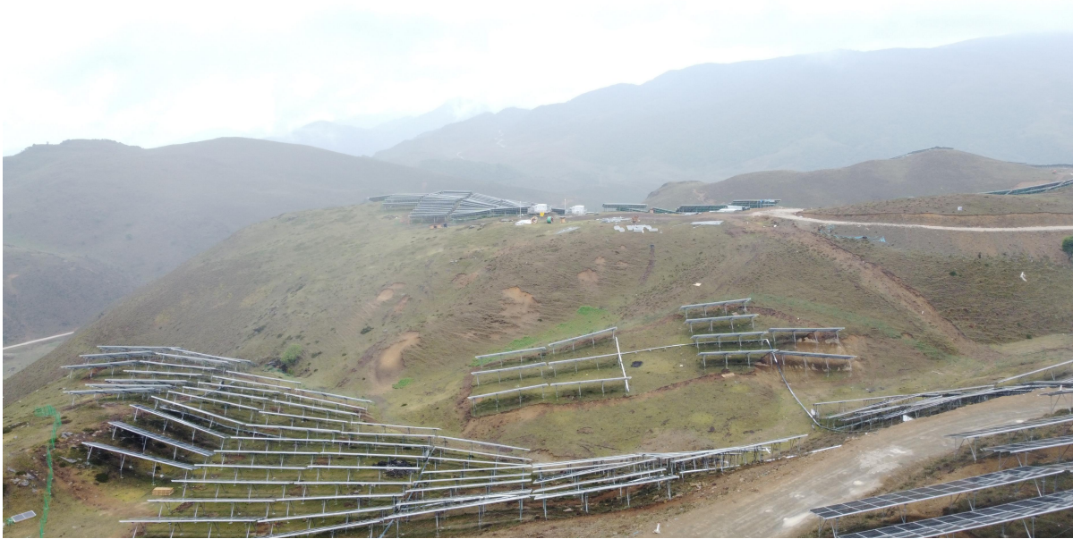
图 3.14 光伏区场内道路大致走向（2023 年 6 月）
