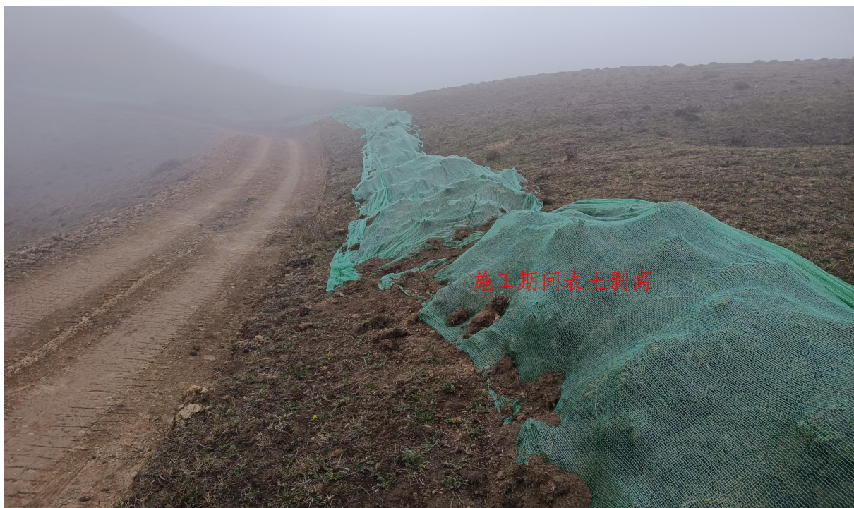
图 3.19 道路工程区表土剥离及无纺布遮盖措施（引自监测照片）
