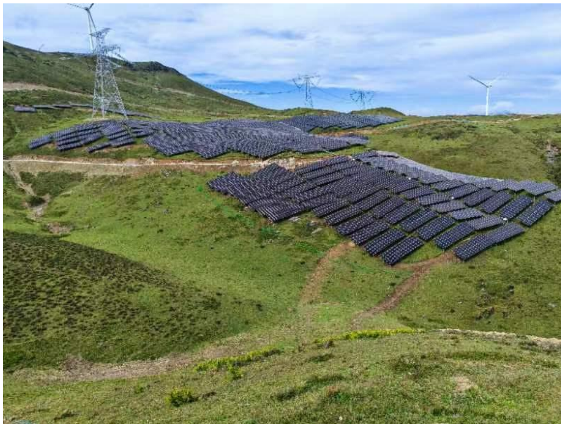
图 3.17 光伏碎石道路填方边坡（2023 年 8 月）
