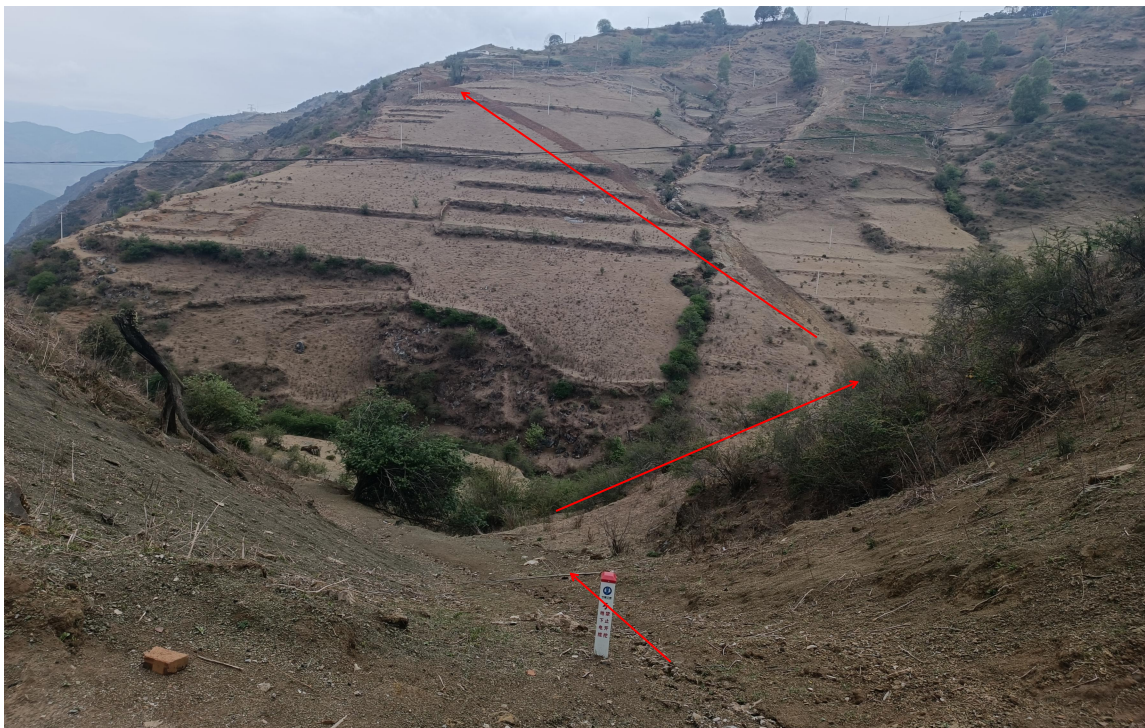
图 3.12 集电线路工程区沟槽区域完成土地整治（2023 年 3 月）
