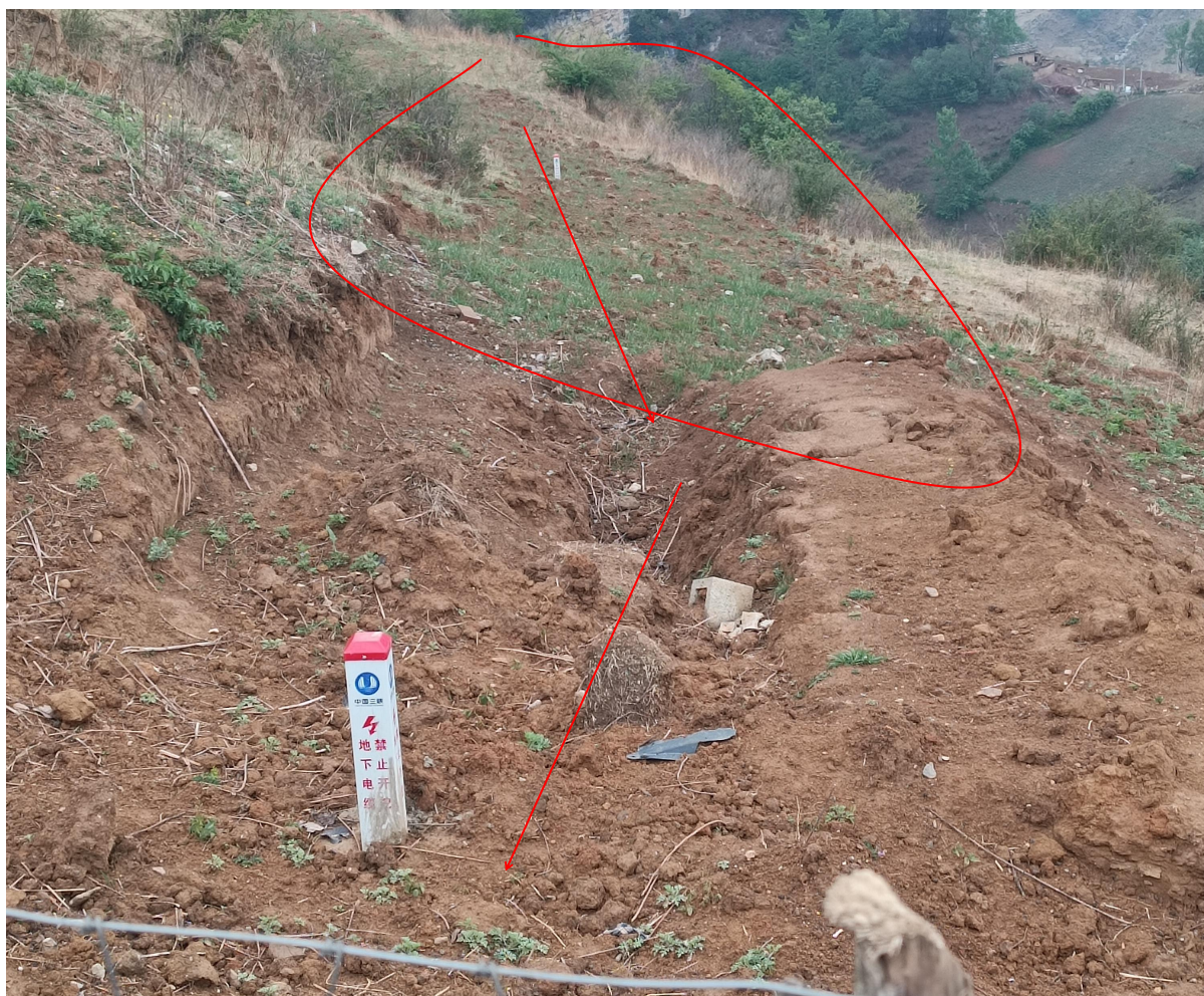
图 3.11 集电线路区沟槽覆土后撒播草籽（2023 年 5 月拍）
