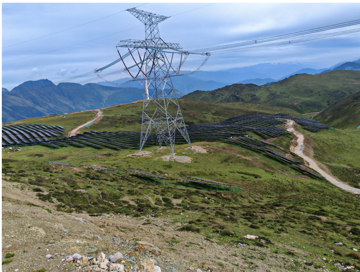
图 3.16 光伏区场内道路整体走向（2023 年 8 月）
